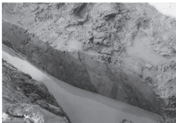
写真15 筵状編み物断面状況 (南から)
