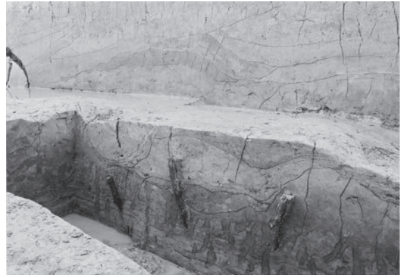
写真18 杭列2基礎部（南から）
