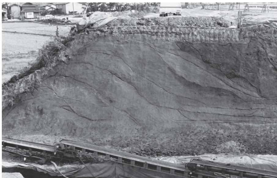
写真66 足守川左岸堤防の土層断面
