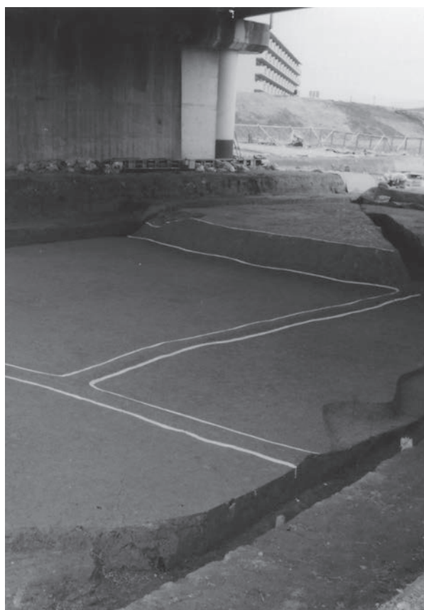
3 水田7微高地取り付け部(西から)
