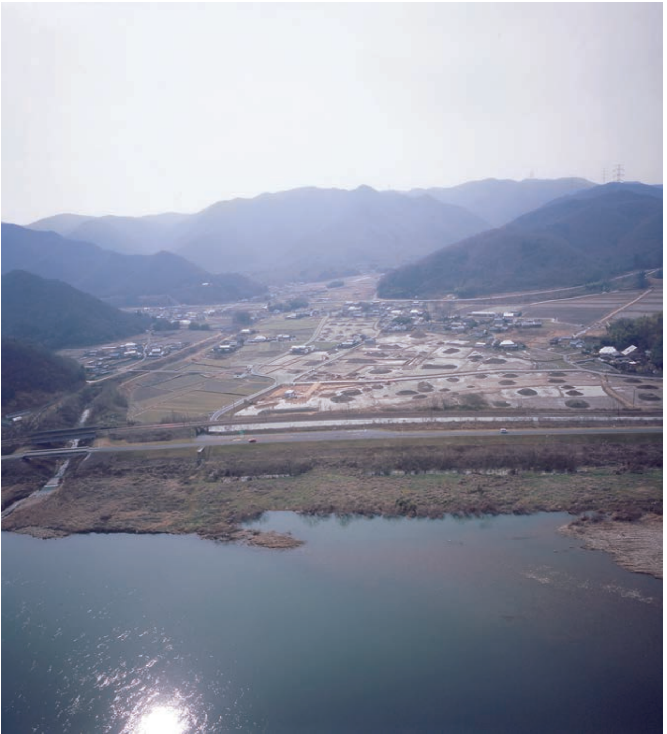
奥吉原地区全景（北上空から）
