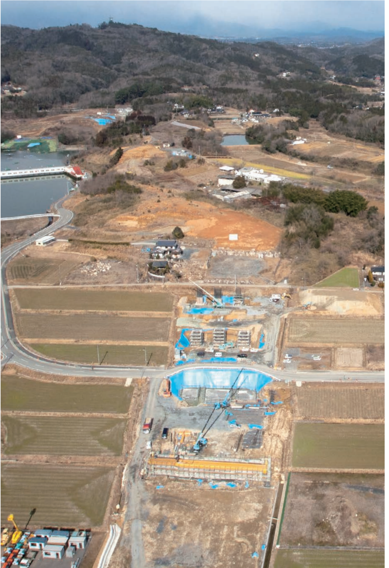
1 調査地全景（南から）
