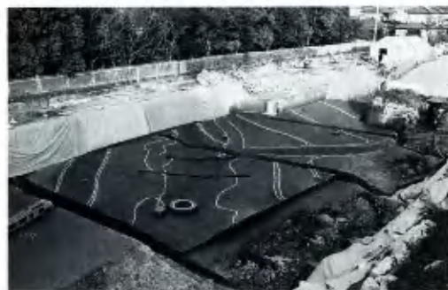
中溝遺跡7区弥生前期水田と溝(南から)
