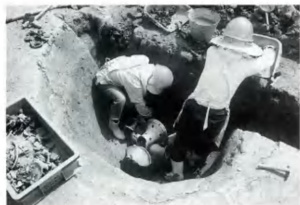
井戸の調査風景
