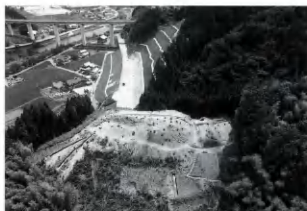
藪澄山城跡全景（北側上空より）
