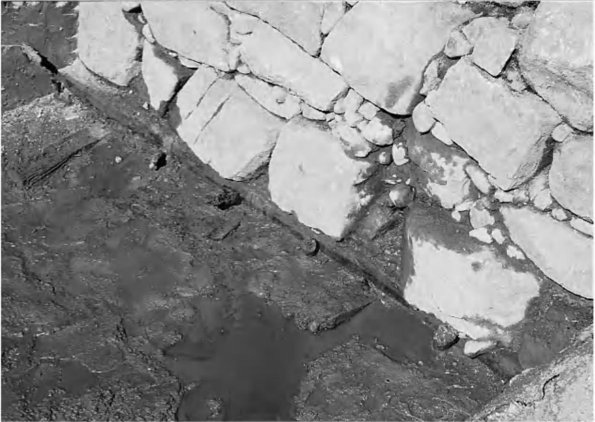
トレンチ13石垣基部（南東から）
