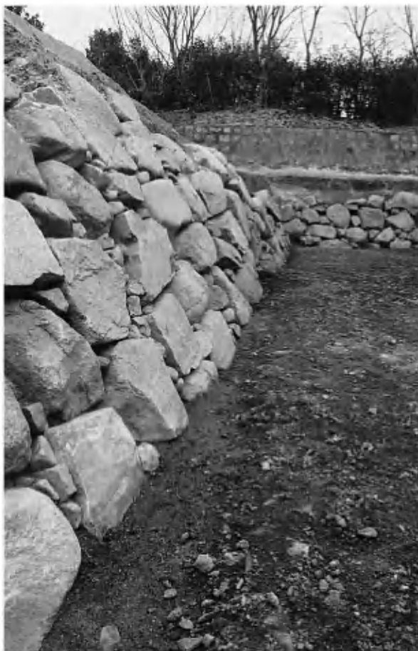
トレンチ 3 石垣 (南西から)
