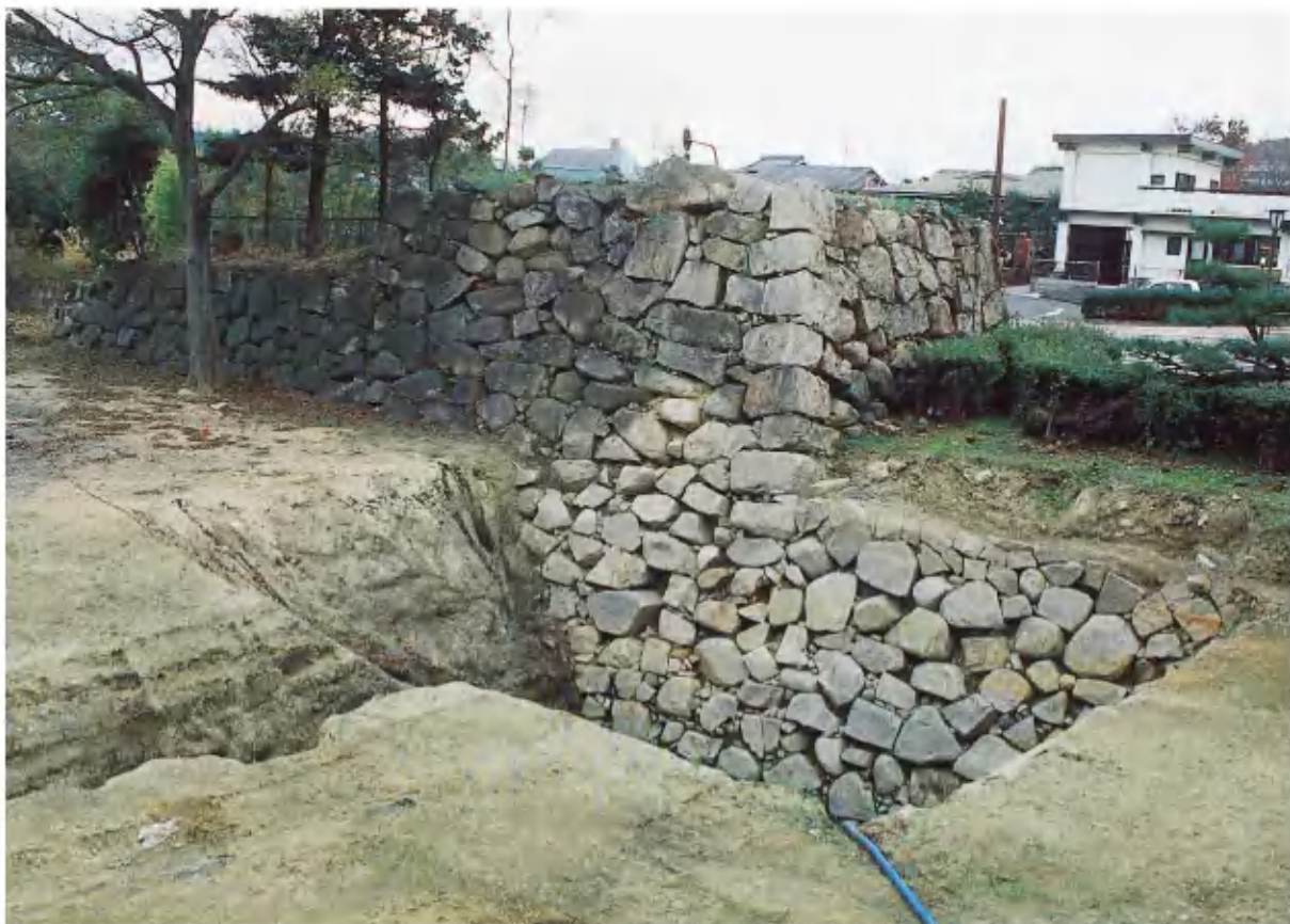
外下馬門石垣全景（南西から）
