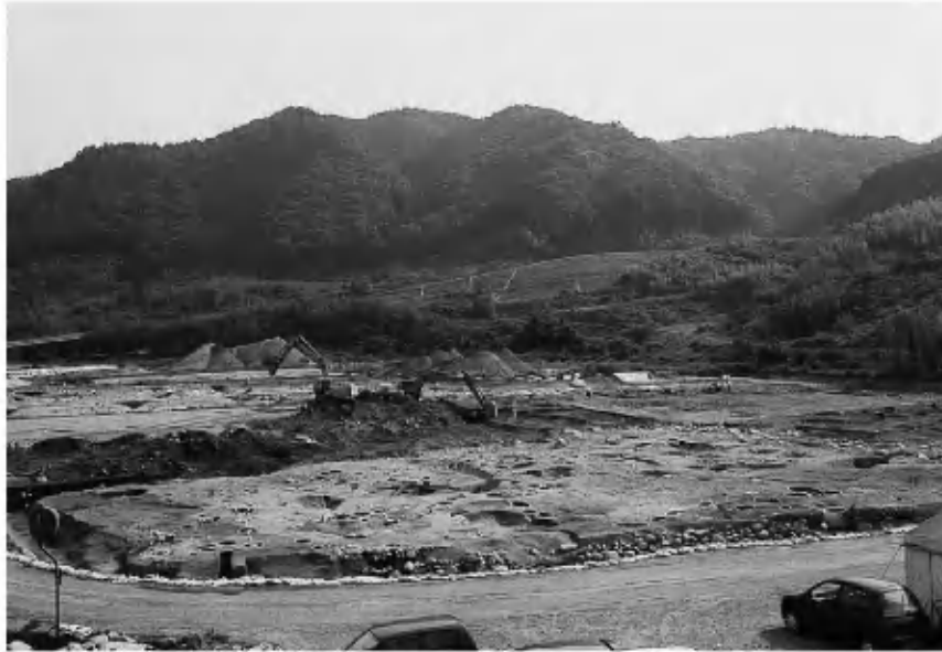
写真51 A地区全景（北から）
