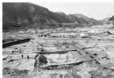
写真7 河道1中流部（南から）
