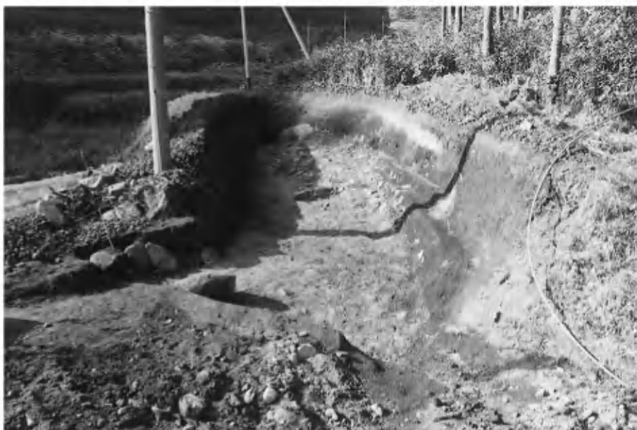
3 1区北側全景 (東から)
