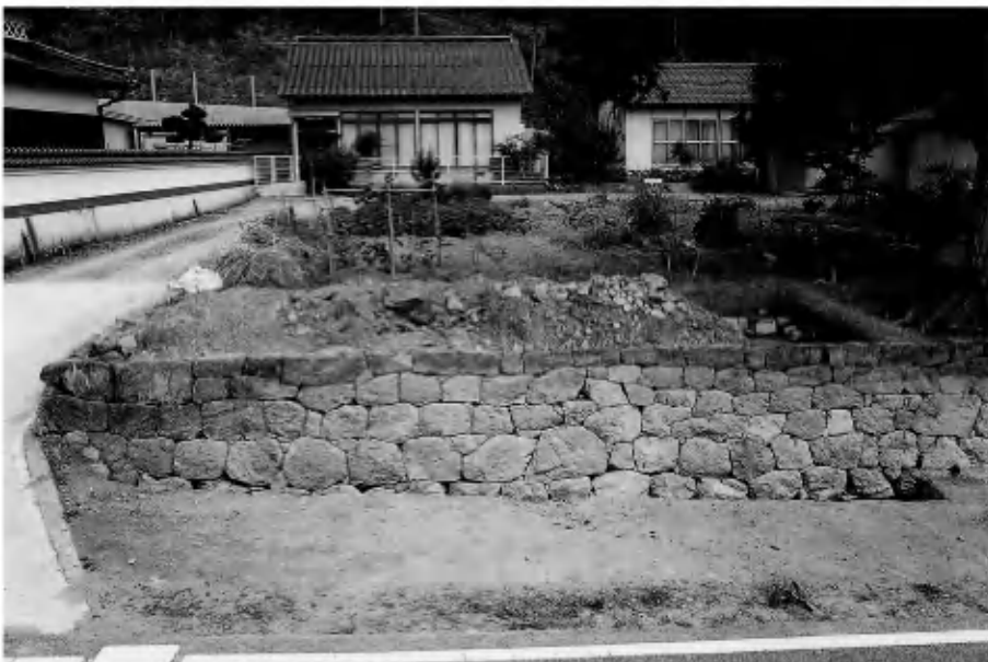
3 石垣<西側> (南東から)
