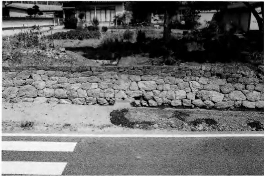
1 石垣 ＜排水穴付近＞ （南東から）
