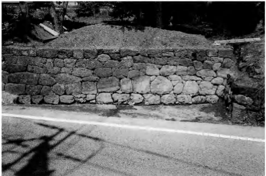
3 石垣＜東側＞ （東から）
