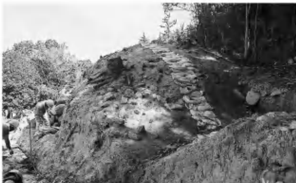
写真5 2号墳墳丘トレンチ埋め戻し状態(南から)
