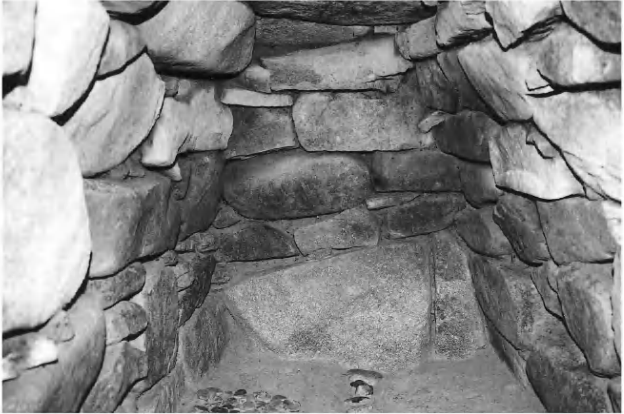
1 2号墳玄室壁面（西から）
