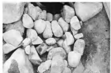
写真12 閉塞施設④（最上部・西から）
