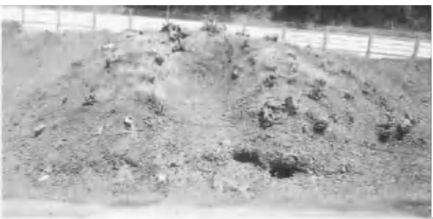
1 5号墳調査前（南から）
