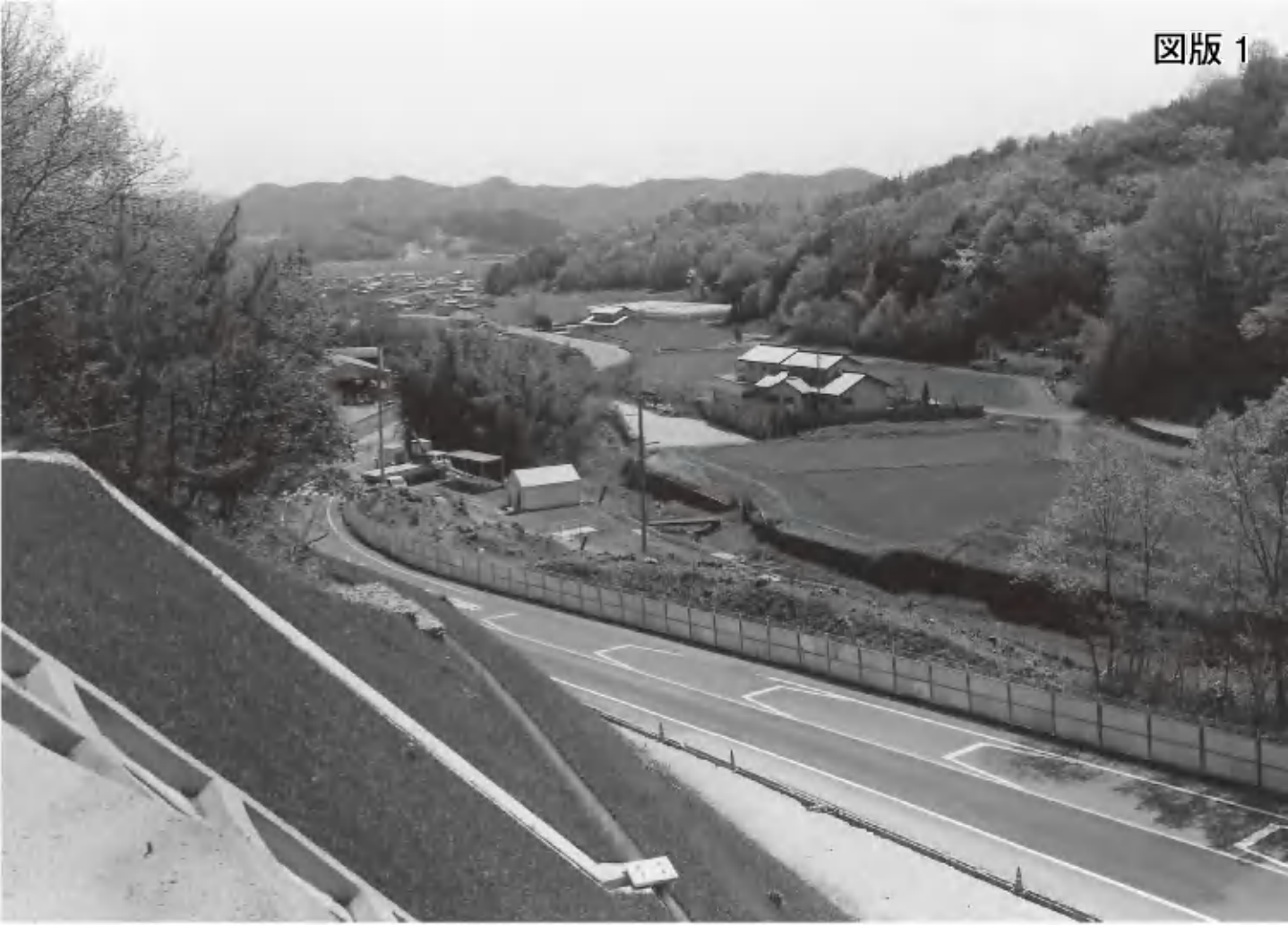
1 調査前（北西から）
