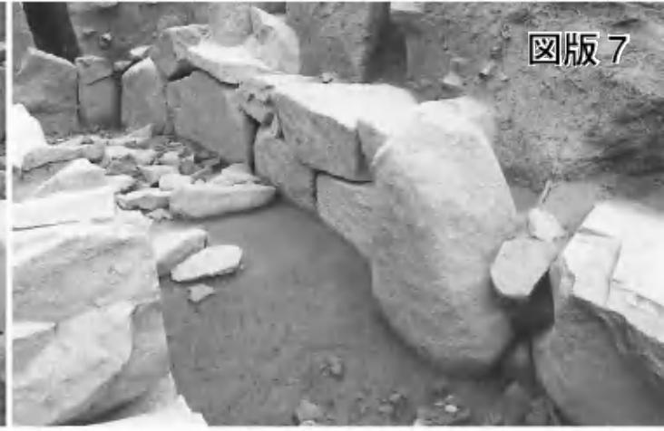
2 5号墳東側側壁（南西から）
