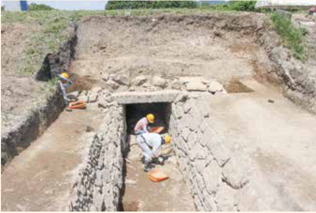
百間川側の暗渠開口部（東から）
