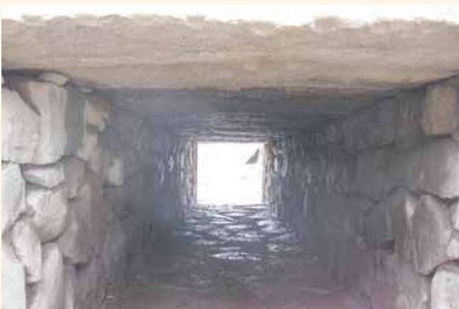
百間川側から見た暗渠内部（東から）
