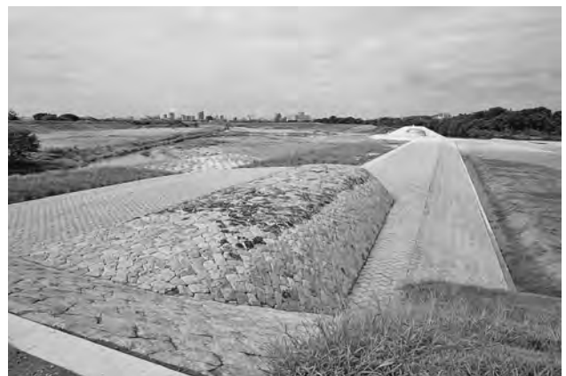
第2図 整備後の治水施設（一の荒手：北から）
