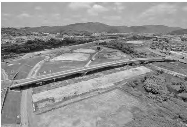
第1図 百間川分流部の全景（南西から）
