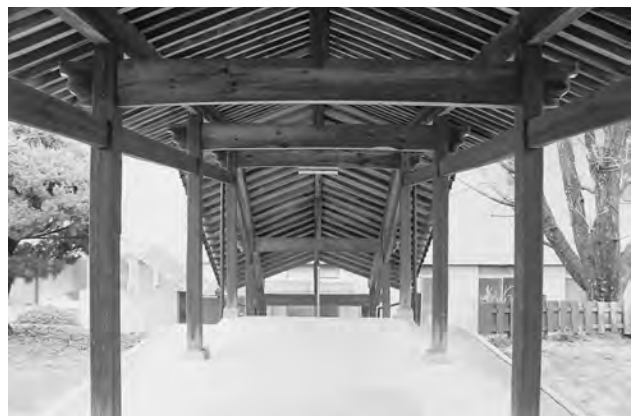
渡り廊下内部（北西から）
