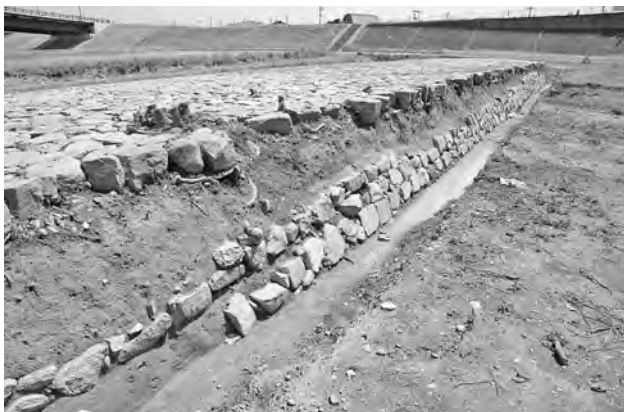
第10図 二の荒手越流堤上流側法面（北から）
