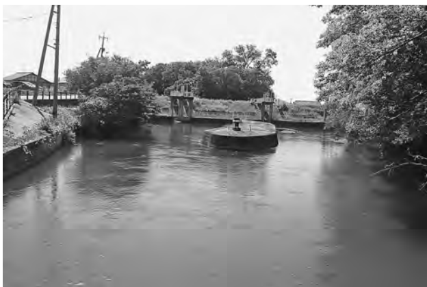
第11図 上流から見た祇園大樋（北から）
