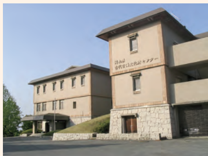
古代吉備文化財センターの外観
