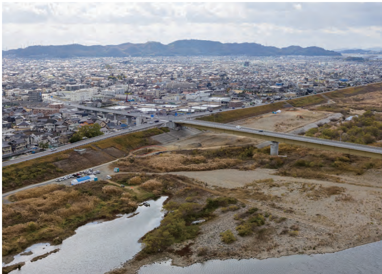
1 調査地遠景（北上空から）
