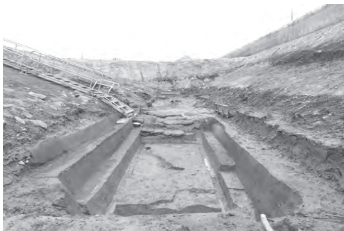
写真1 2区全景（南西から）
