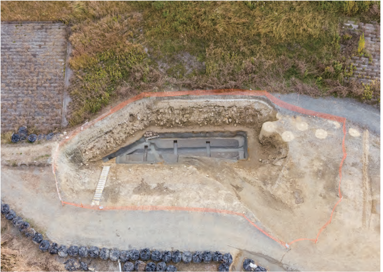
1 1区上層全景（北西上空から）
