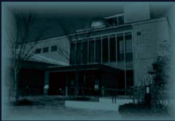
平成12年7月13日 真備町立図書館 開館 平成17年8月1日～ 倉敷市立真備図書館に 平成30年7月7日～ 豪雨浸水被害のため休館
