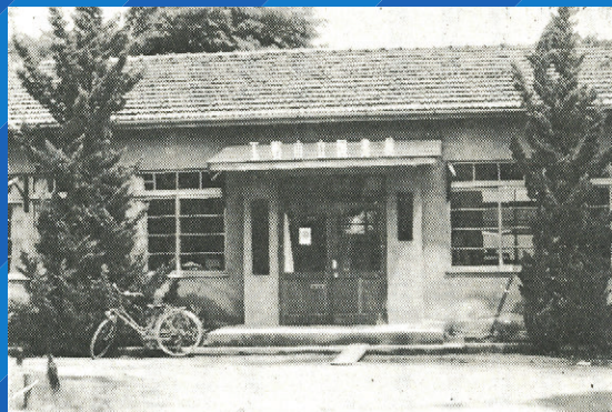
本館として図書館独立（昭和 30 年）
