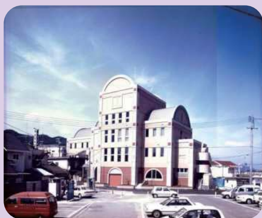
平成 4 年 和氣町立図書館外観
