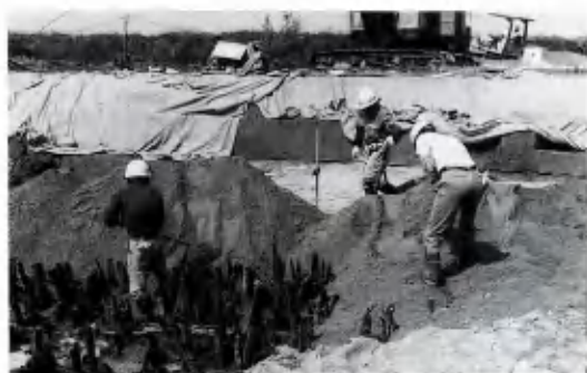
保存のための砂締め作業
