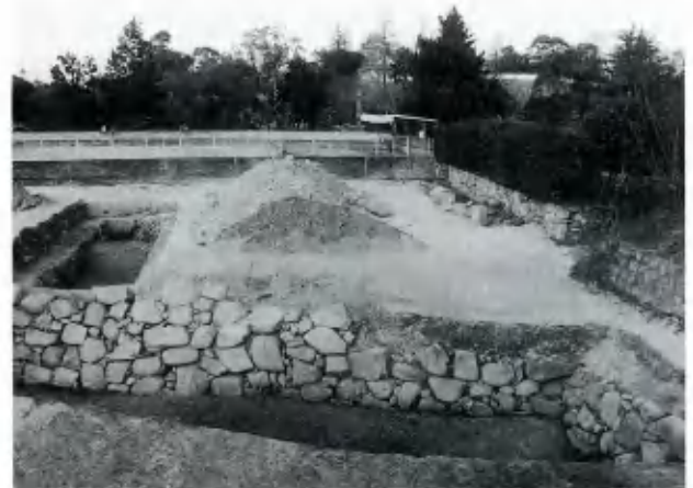
二の丸(内部)南・西面角の石垣(南から)
