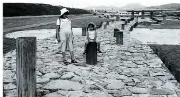
太い丸太が橋脚です（写真奥は沢田橋）
