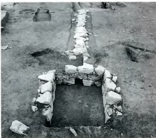
榎馬場の排水施設（南から）
