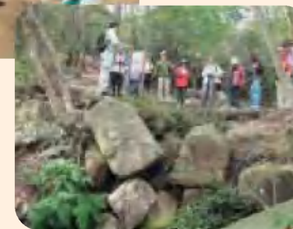
第4水門付近の石垣
