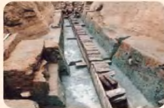
木樋管全景（北から）
