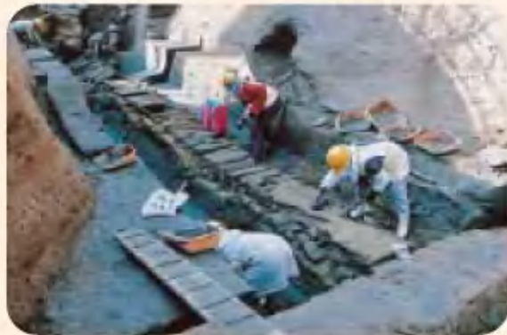
木樋管被覆粘土（北東から）
